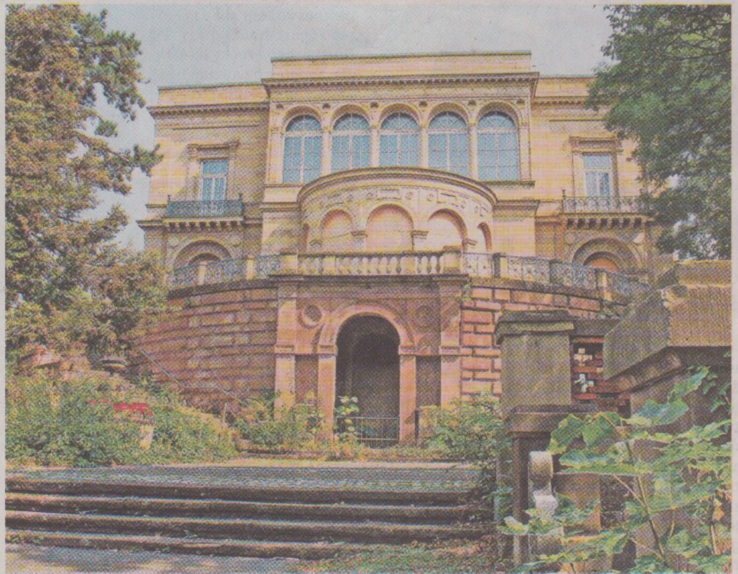
Die Villa Berg verfällt zunehmend.
